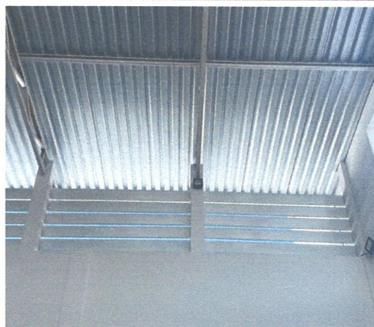
FOTO 184: Instalação e pintura dos brises
