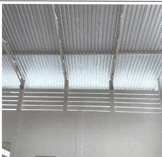
FOTO 186: Instalação e pintura dos brises
